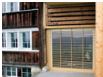
Gais AR, Luser. Im Raum zwischen Wohn- und Stallteil ist eine grosse Öffnung in der Aussenwand möglich. (Bilder Emanuel Sturzenegger; kant. Denkmalpflege)
