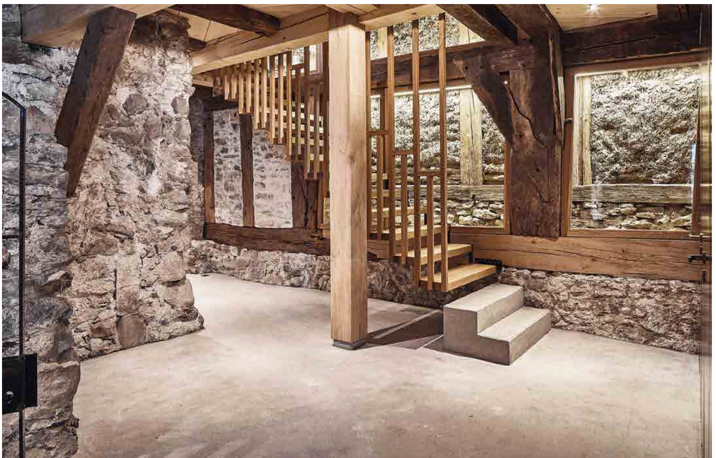
Le mur coupe-feu appartient à la propriété voisine et a été séparé par un vitrage anti-feu.
