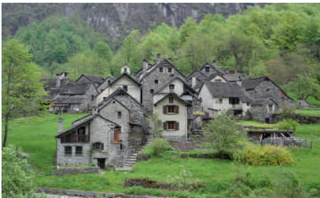
Die Bavonesi bauten getreu einer alten und bewährten Tradition. Ihre Kunst bestand darin, auf alle Anforderungen eine einfache bauliche Lösung zu finden und den vorhandenen Platz sparsam zu nutzen. Typische Wohnhäuser, wie sie im 16. Jahrhundert entwickelt wurden, können heute in Roseto (Bild) oder in anderen Weilern wie Mondada und Sabbione bewundert werden. (Bild SHS)
