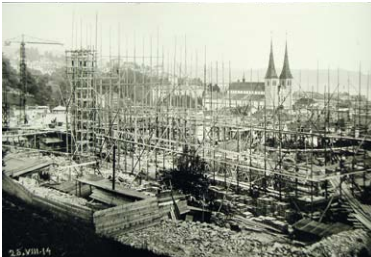
Baustelle der Suva an prominenter Lage in Luzern
