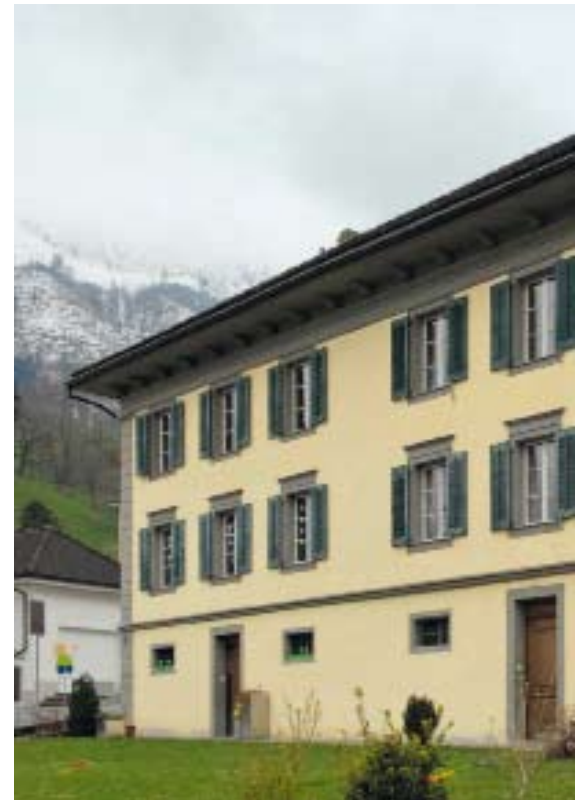
Stans, Kaplanenhaus, Knirigasse 2, Baujahr 1846, Ansicht von Nord-Osten (Bilder Fachstelle für Denkmalpflege Nidwalden)
