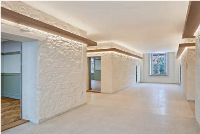
Freigelegtes Mauerwerk in den Gängen erzählt die Geschichte des Gebäudes. La maçonnerie apparente dans les couloirs raconte l'histoire du bâtiment.
