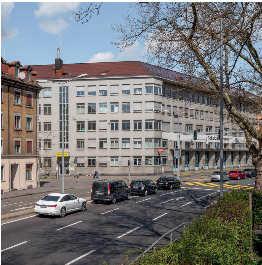
Dachsanierung Schutz und Rettung, Zürich (Bild: Pierre Marmy, SHS)
